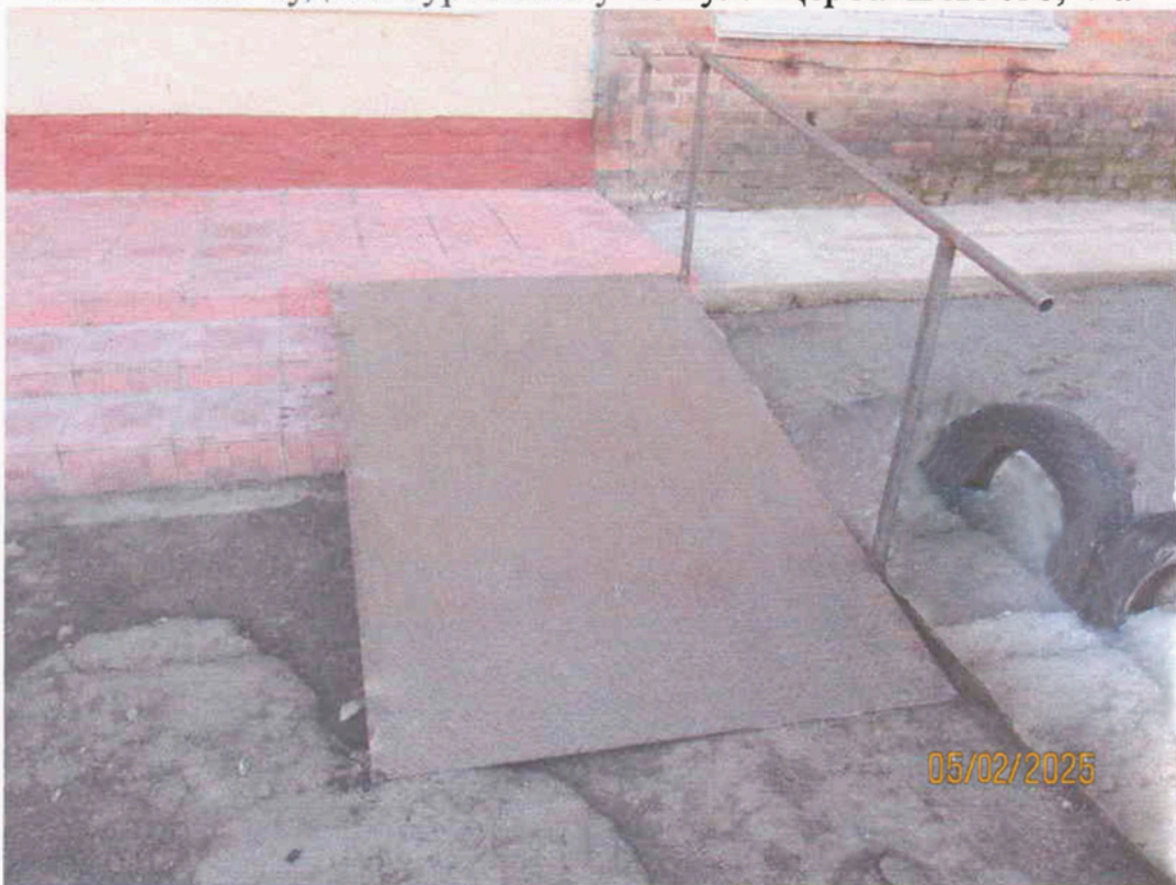
Мал. 2. Зовнішній вигляд пандуса для мало мобільних груп населення до нежитлової будівлі гуртожитку по вул. Щербаківського, 4-а
